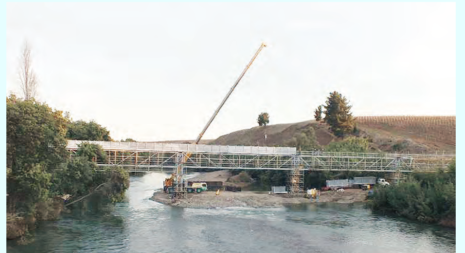
Montaje nueva canoa metálica sobre estructura reforzada.
