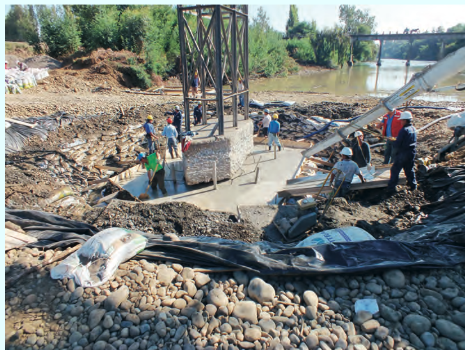
Mejoramiento y reforzamiento de pilastras de canoa con micropilotes.
