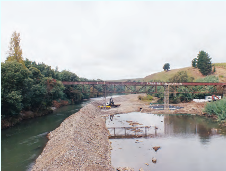
Intervención de Río Bureo para reparación de pilastras de Canoa.
