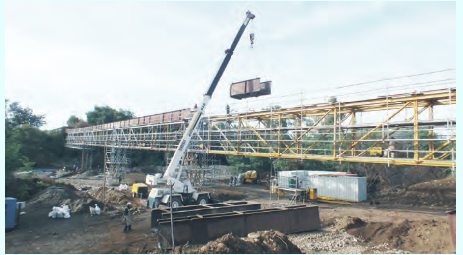
Desarme de antigua canoa metálica desde estructura reforzada.
